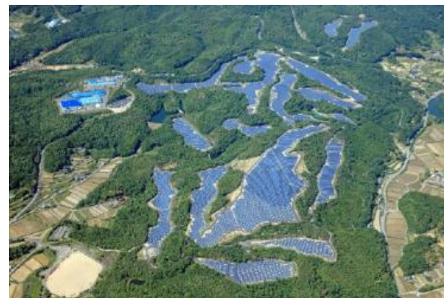
久米南メガソーラープロジェクト/ 出典：パシフィック・エナジー株式会社
