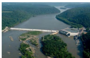
ペンシルベニアの水力発電所 (米国インフラファンド投資事例)
