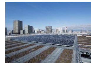
日本生命本店東館（大阪）屋上
